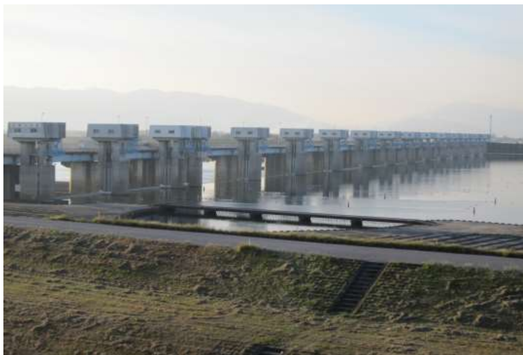
(木曽川用水総合管理所から見た木曽川大堰)
