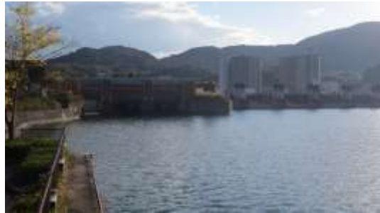
瀬田川洗堰（左側がバイパス）
