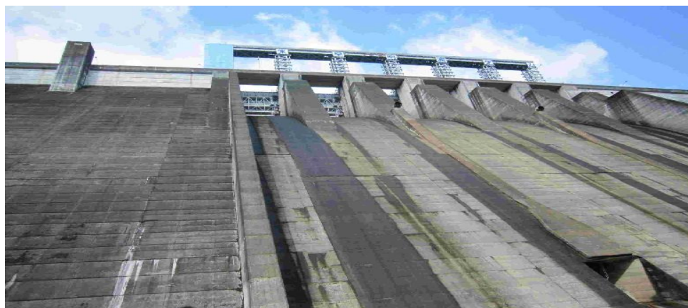
【放流口方面から望む早明浦ダム】
