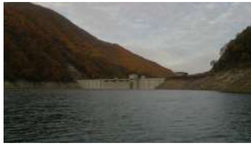
【湖面より見た湯西川ダム】
