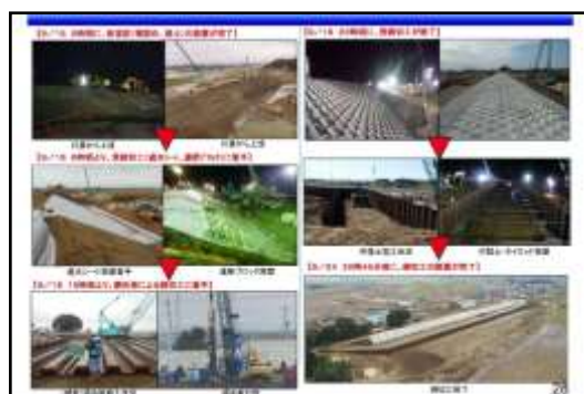
【鬼怒川決壊箇所への復旧状況】
