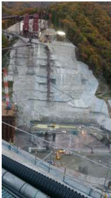
【八ッ場ダム建設状況】
