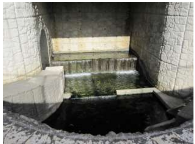
地下ダム止水壁の地上露出部分
